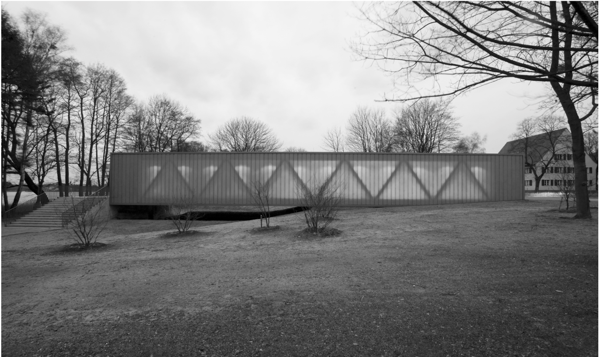
Informationszentrum Gedenkstätte Ravensbrück, Wandel, Hoefer, Lorch Architekten
